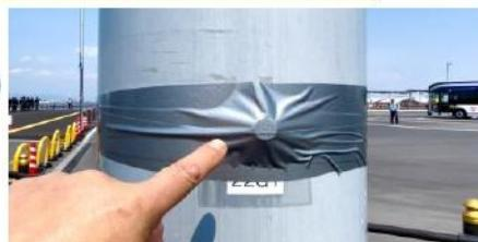
高濃度のメタンガスが検出されてきた管の一つ。ガス検知孔を塞ぐ簡易ボルトは緩い。
