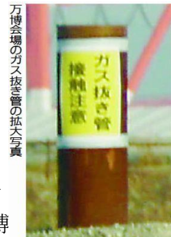
万博会場建設現場に林立するガス抜き管。「接触注意」と書かれています(本誌事前の写真)
